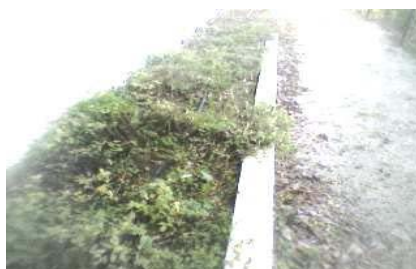
Estado dos canteiros.
